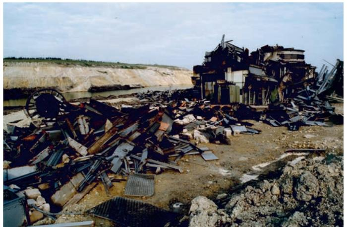
Im September 1982 förderte der Schaufelradbagger 4 die letzte Tonne Kohle aus dem Wackersdorfer Braunkohlerevier – viele der Großgeräte wurden danach gesprengt, wie der hier abgebildete Bandabsetzer.
